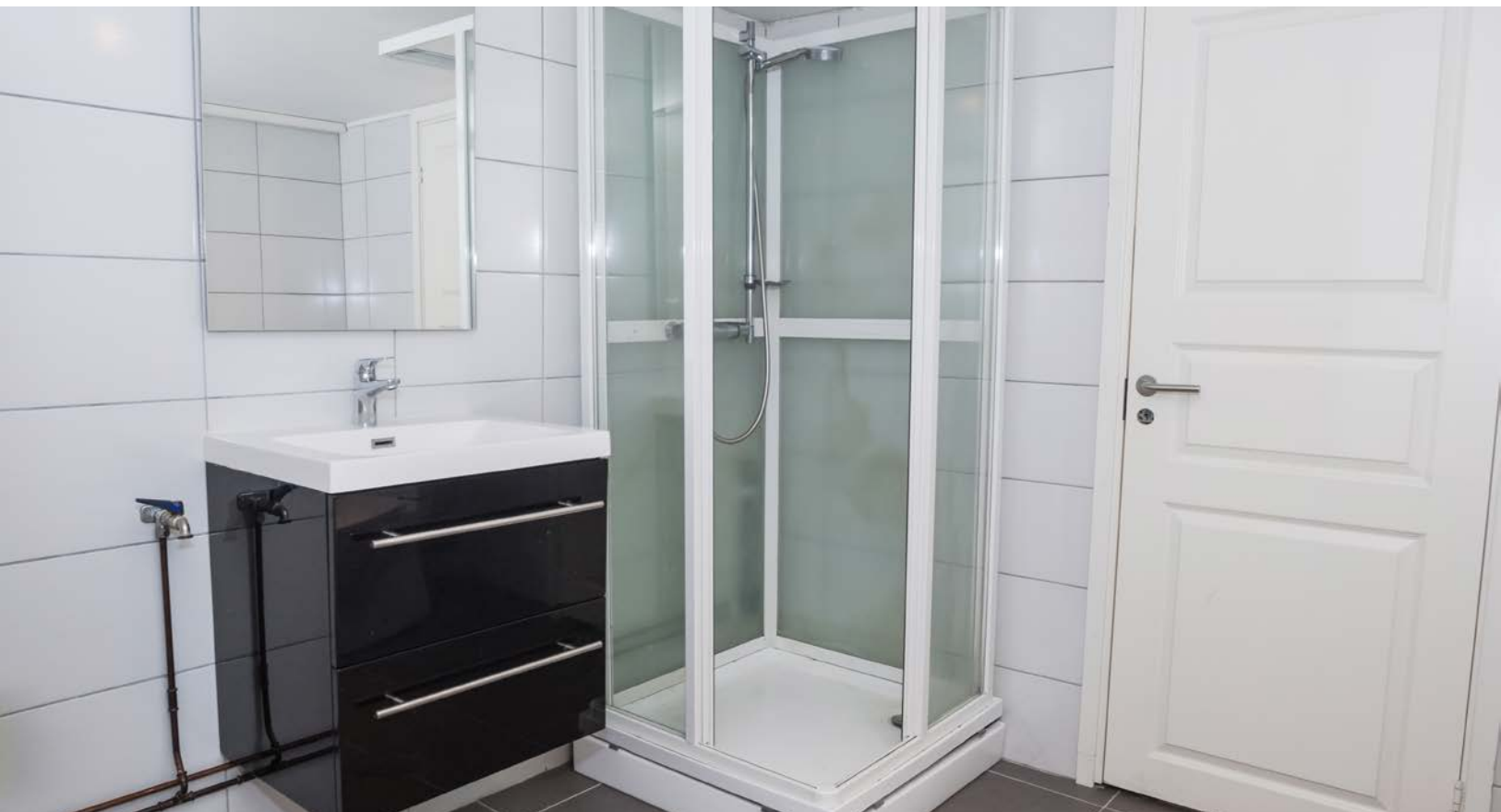
Hybeldelen har et moderne baderom fra 2018. Badet har mørke fliser på gulv, lyse fliser på veggene og mekanisk avtrekk. Plass og opplegg for vaskemaskin.
