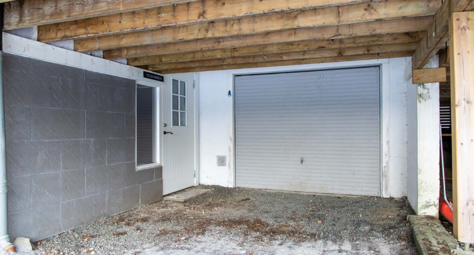
Gode parkeringsmuligheter i garasje og carport. Her er det også egen inngang til hybeldelen.
