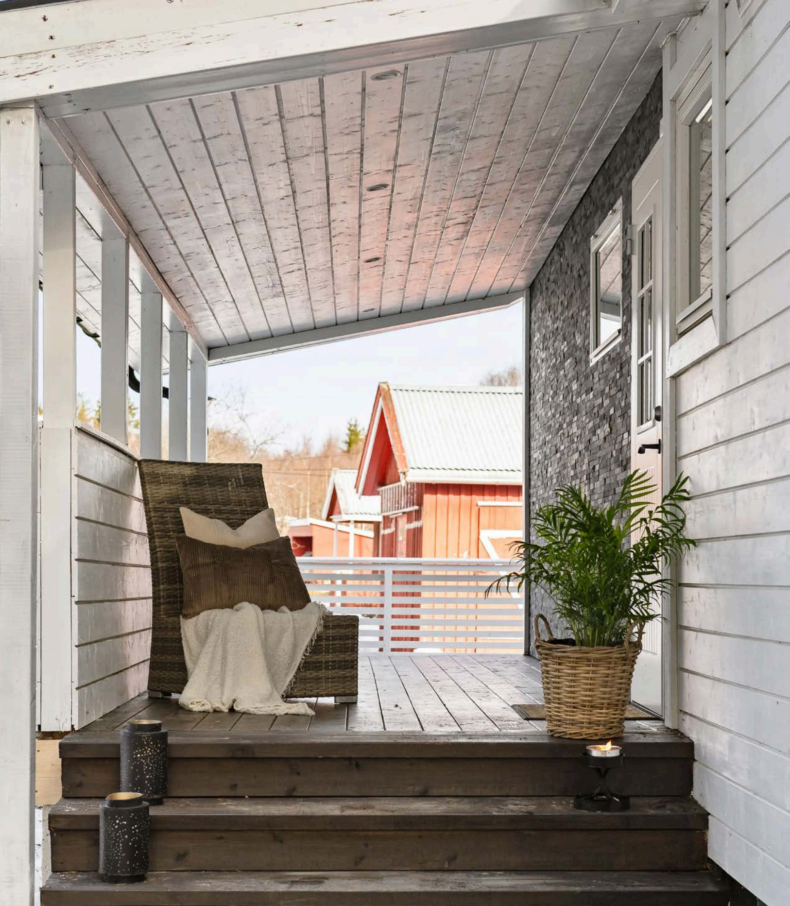
Overbygget inngangsparti med downlights i himlingen.
