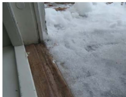
Kort avstand mellom dør og balkong gulv.
