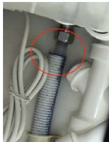
Det mangler tetteffter på enden av varerørene på kjøkkenet.
