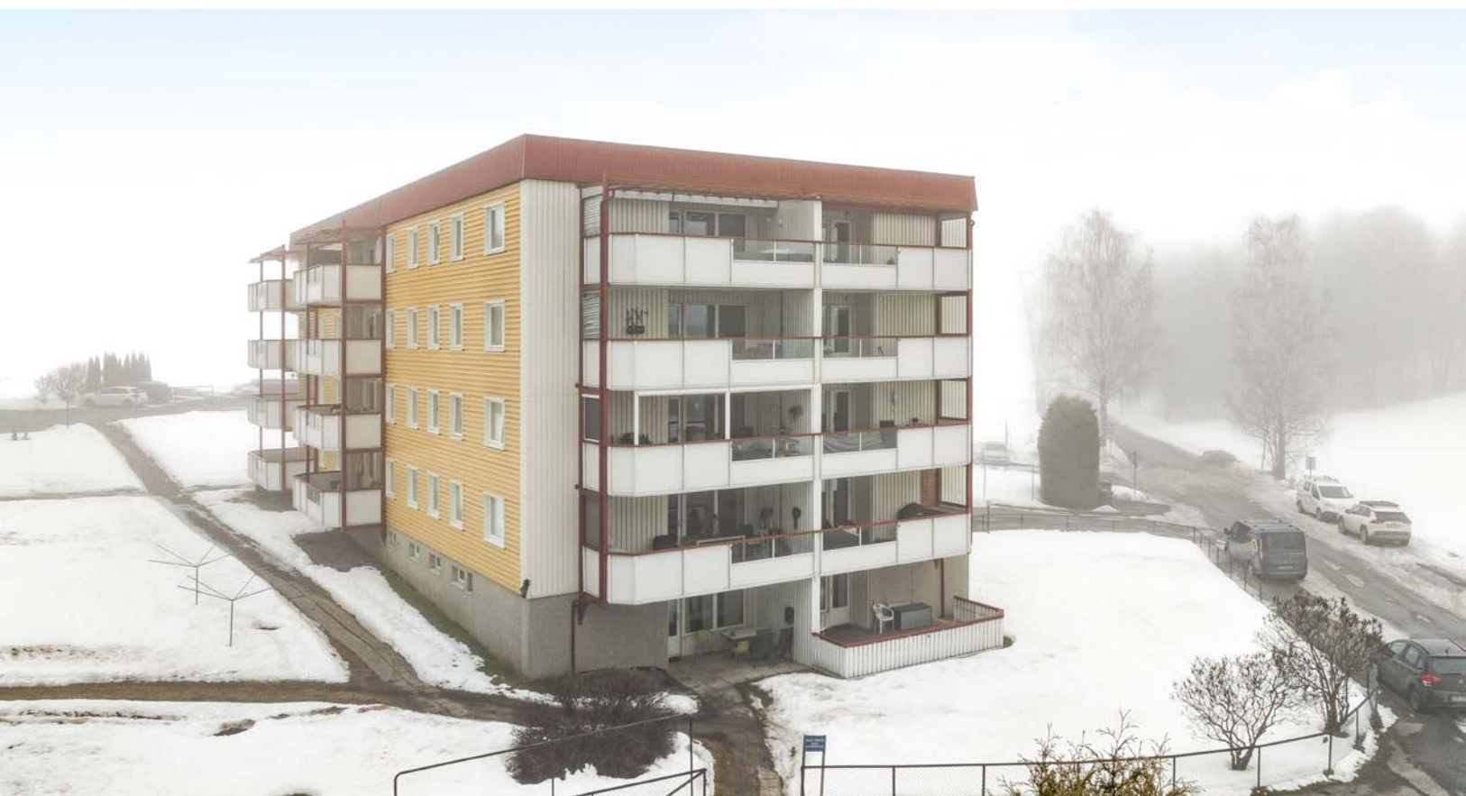
Leiligheten ligger i byggets 3. etasje.
