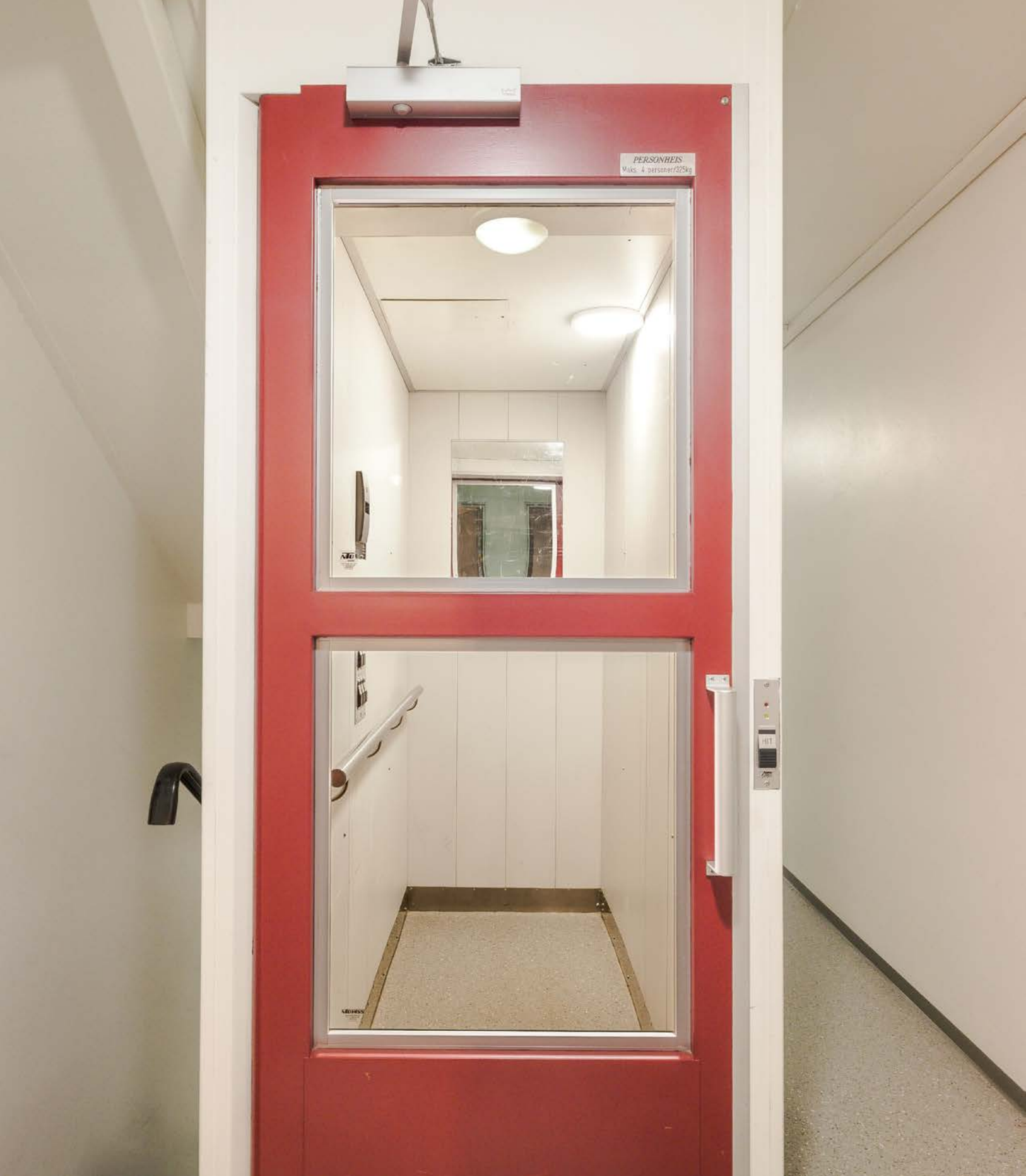
Bygget har personheis.
