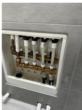
Nytt fordelingskap i baderom 2. etasje.
