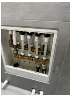
Nytt fordelingskap i badet 2. etasje.
