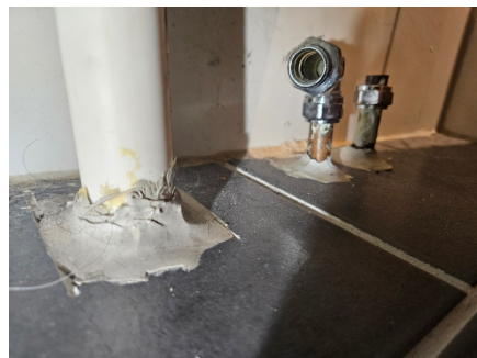
Ørgjennomføring i gulv.
