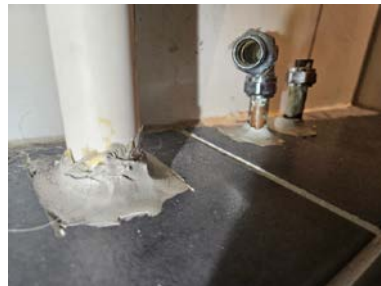
Ørgjennomføring i gulv.
