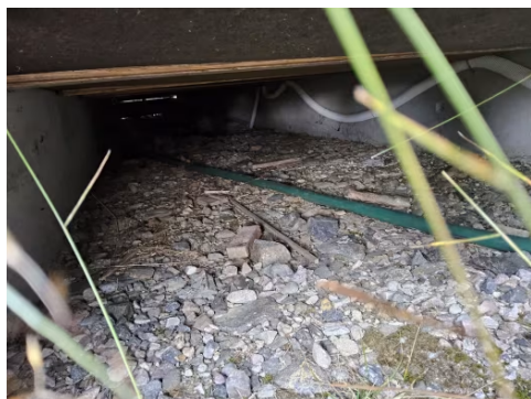
Bildet viser stripefundamenter.
