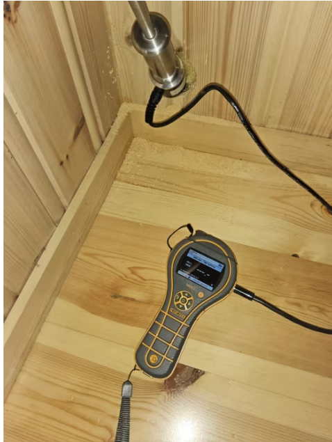
Fuktmåling mot dussjonen.
