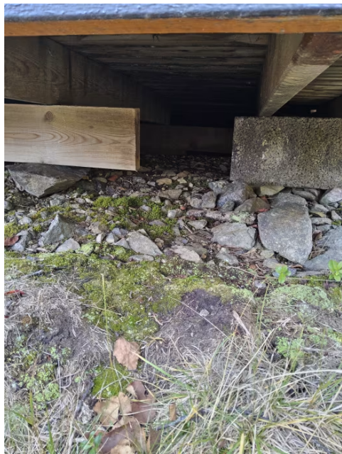
Terrassen har provisorisk fundamentering.
