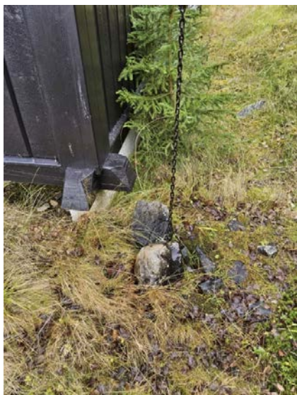
Bildet viser nedløpskjetting.
