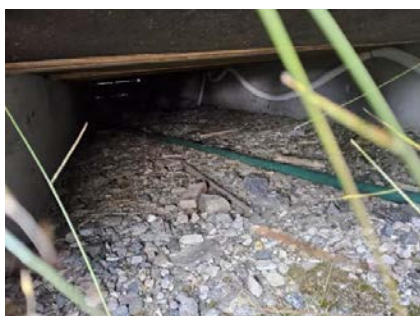
Bildet viser stripefundamenter.
