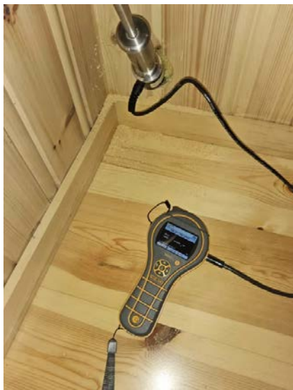
Fuktmåling mot dussjonen.
