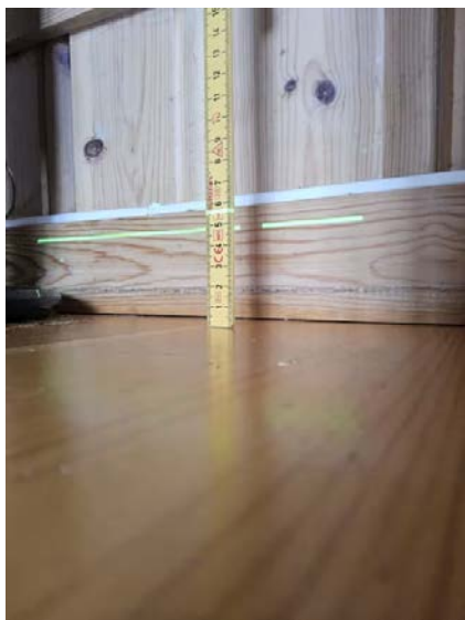
Skjevhetmåling - Ingen vesentlige avvik ble registrert.
