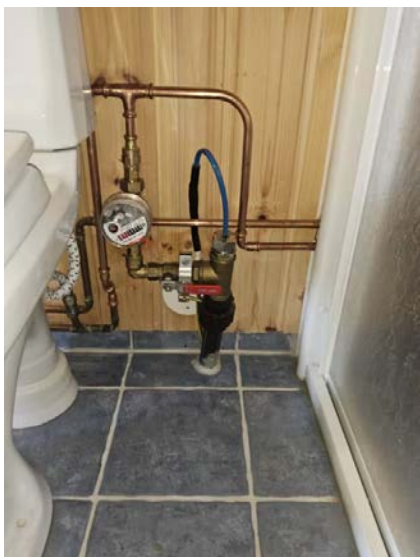
Rørplegg på bad.
