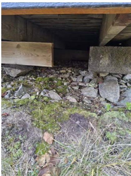
Terrassen har provisorisk fundamentering.
