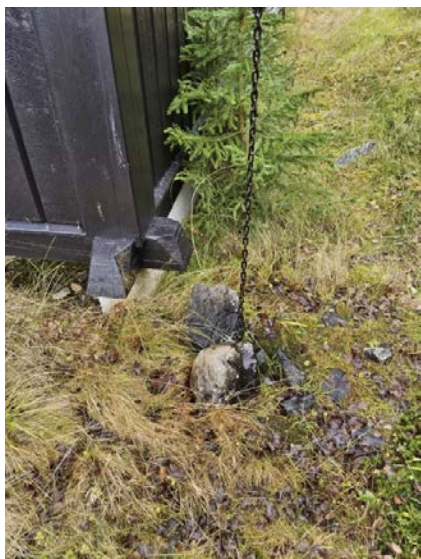
Bildet viser nedløpskjetting.
