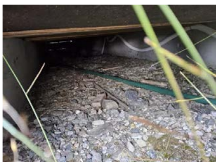
Bildet viser stripefundamenter.
