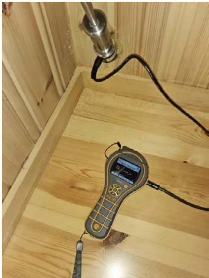
Fuktmåling mot dusjsjonen.
