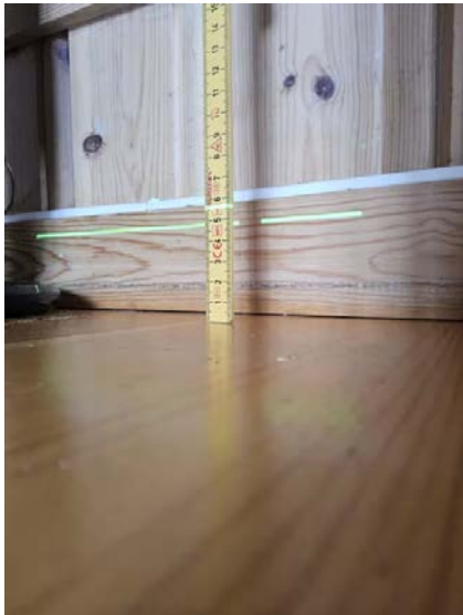
Skjevhetmåling - Ingen vesentlige avvik ble registrert.
