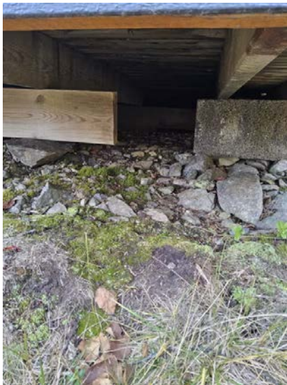
Terrassen har provisorisk fundamentering.
