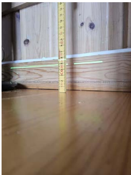
Skjevhetmåling - Ingen vesentlige avvik ble registrert.
