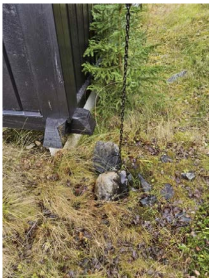
Bildet viser nedløpskjetting.
