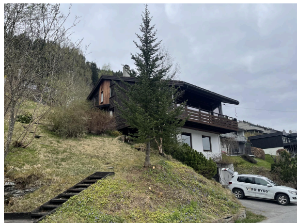
Fasade mot sør og vest. Asfaltert innkjørsel til garasje i kjeller.
