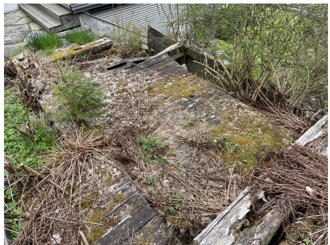
Rivningsklar terrasse på nord-aust sida av konstruksjonen.
