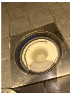
Plastsluk med klemring for membran
