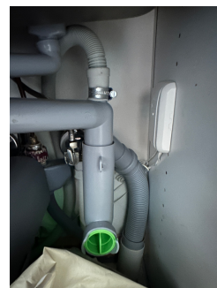
Rørapplegg i kjøkkenbenk med Waterguard
