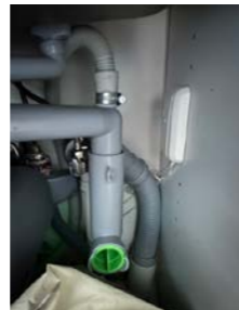
Rørapplegg i kjøkkenbenk med Waterguard
