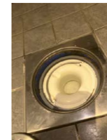
Plastsluk med klemring for membran
