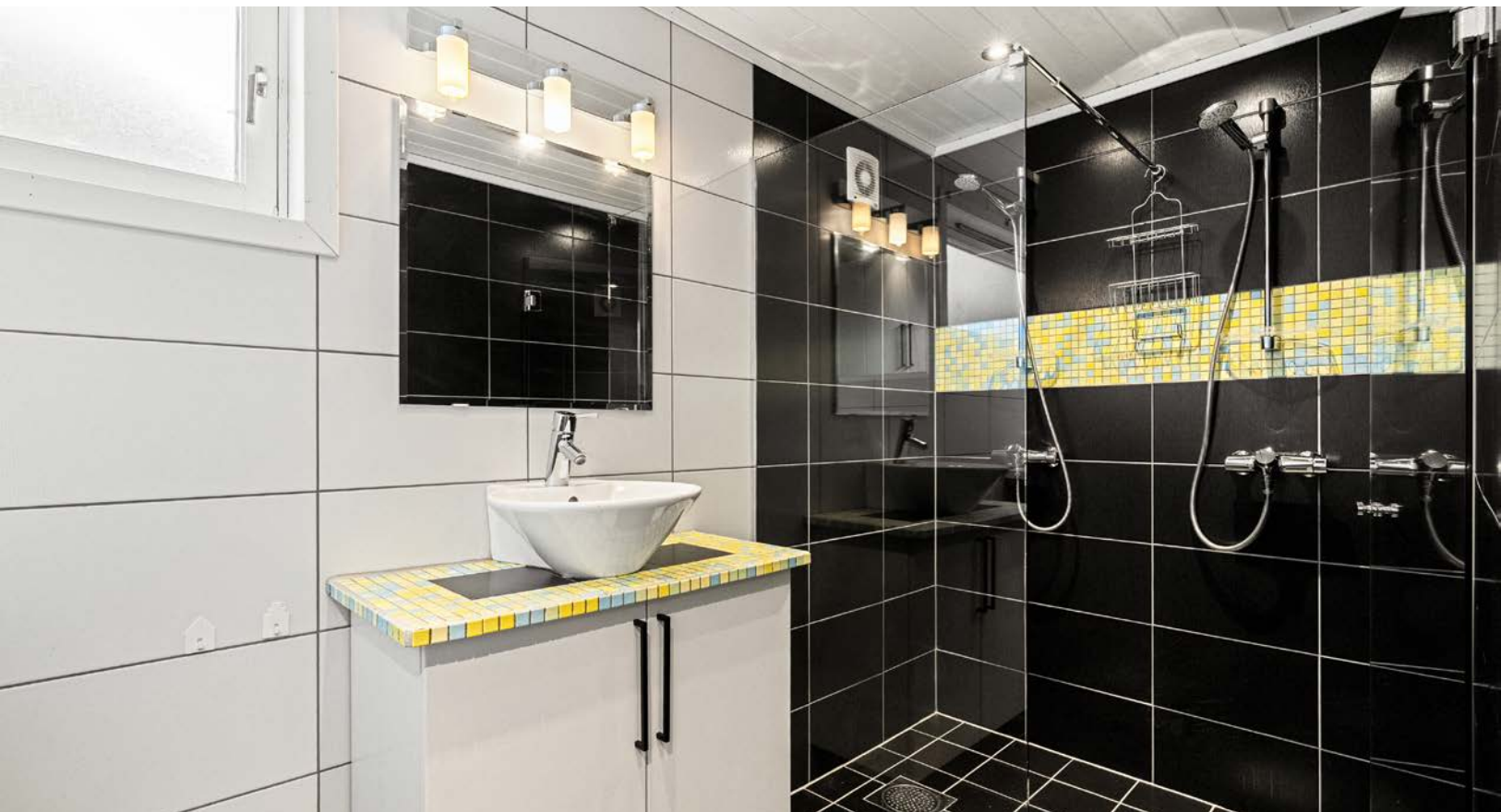
Badet har fliser på vegger og gulv, med elektriske varmekabler og malt tak. Rommet har innredning med servant, dusjhjørne med vegger.
