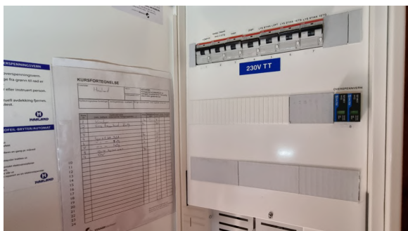
Kontroll av el-skapet.
