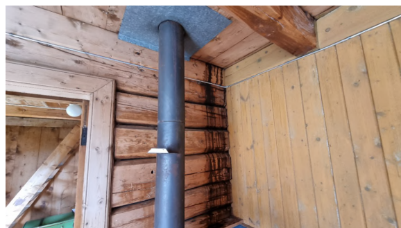
Flere røykrørgjennomføringer i etasjeskiller.
