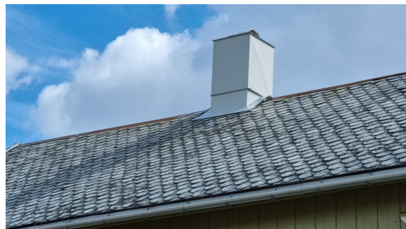
Visuell besiktelse av taket.
