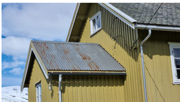
Visuell besiktelse av taket over bi-inngang.
