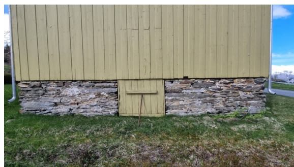
Adkomst til krypkjeller via luke i grunnmur.
