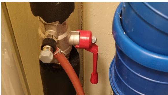
Kontroll av hovedstoppekran.
