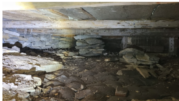
Inspeksjon av krypkjeller.
