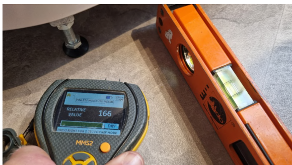
Fuktmåling og kontroll av fall mot sluk.
