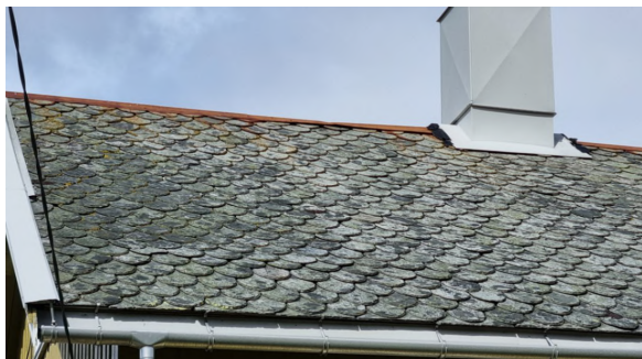
Visuell besiktelse av taket.
