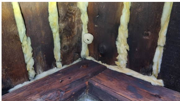
Vepsebol på loftet. Legge merke til at det er dyttet Glava i mellom trobord.
