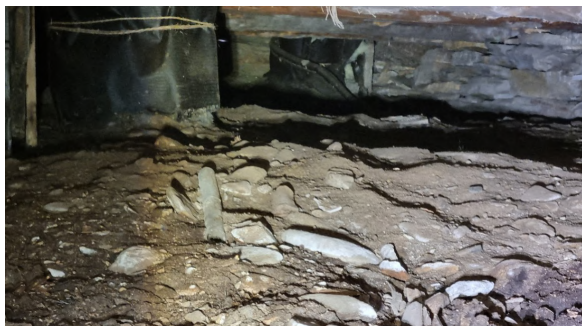
Inspeksjon av krypkjeller.
