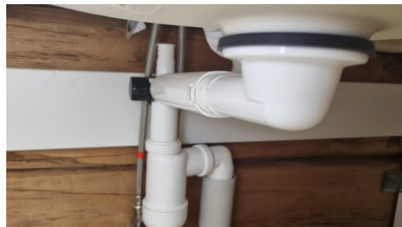
Kontroll av røropplegget under servanten.
