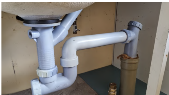
Kontroll av røropplegg under oppvaskkummen.
