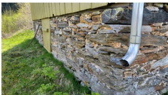
Kontroll av grunnmur.
