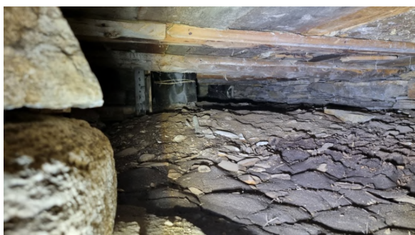
Inspeksjon av krypkjeller.
