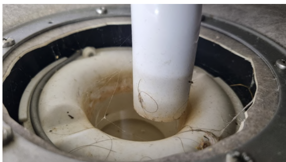
Kontroll av sluk.
