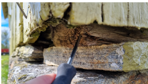
Kontroll av bunnsvill.
