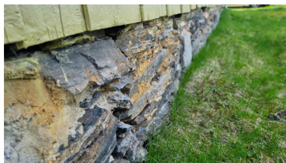
Kontroll av grunnmur.
