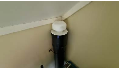
Lufting av kloakken.
