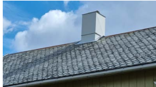
Visuell besiktelse av taket.
