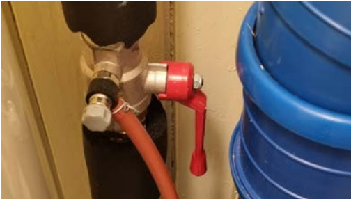
Kontroll av hovedstoppekran.
