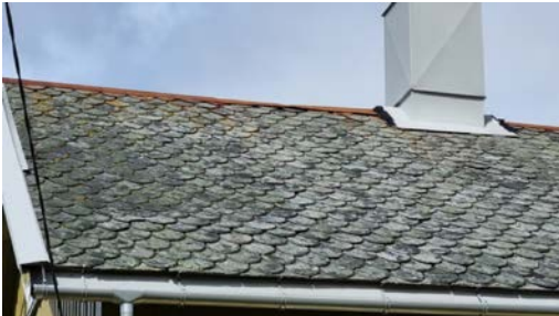
Visuell besiktelse av taket.
