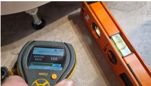
Fuktmåling og kontroll av fall mot sluk.
