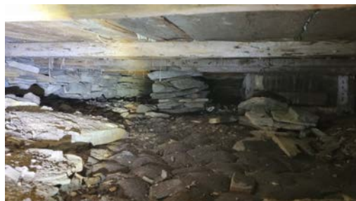
Inspeksjon av krypkjeller.
