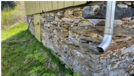
Kontroll av grunnmur.
