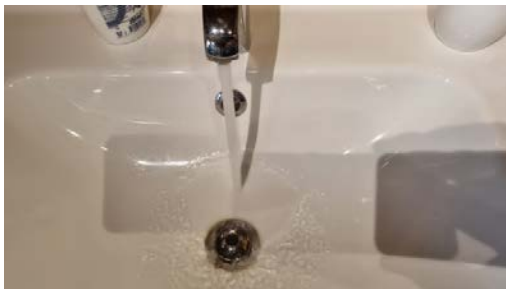
Kontroll av vanntrykk og avrenning.
