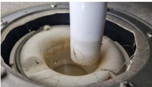
Kontroll av sluk.
