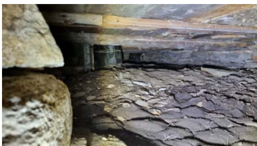
Inspeksjon av krypkjeller.
