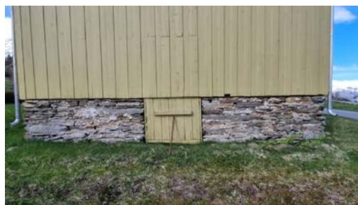
Adkomst til krypkjeller via luke i grunnmur.
