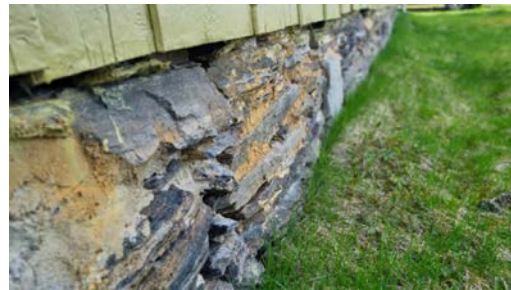
Kontroll av grunnmur.
