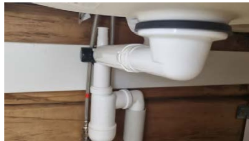
Kontroll av røropplegget under servanten.
