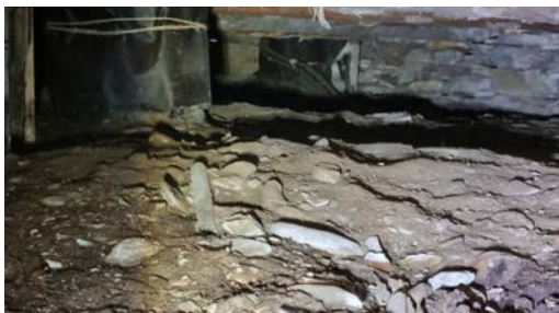
Inspeksjon av krypkjeller.
