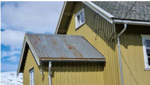
Visuell besiktelse av taket over bi-inngang.
