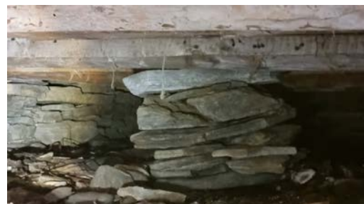
I krypkjeller er enkelte gulvbjelker understøttet av naturstein.
