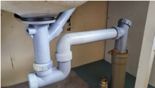
Kontroll av røropplegg under oppvaskkummen.
