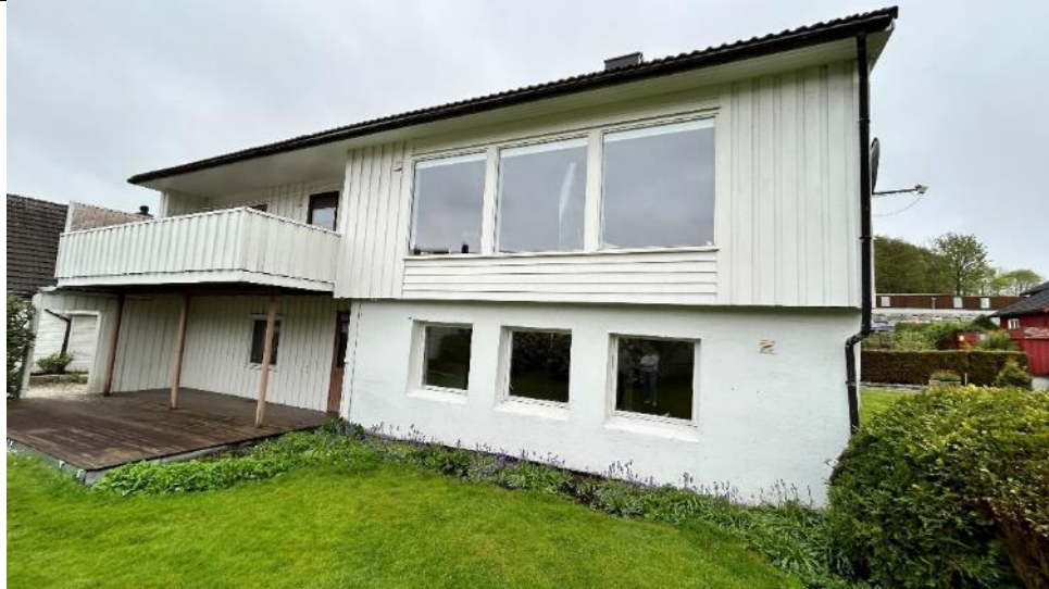
Foto nr. 1 Fasade mot vest.
