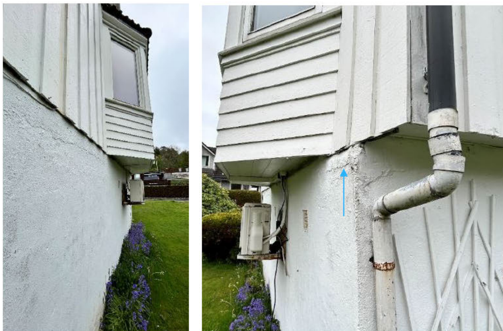
Grunnmur er blitt påstøpt anslagsvis 10cm over opprinnelig grunnmur.
