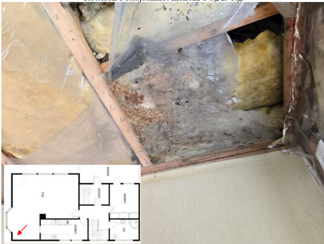
Vedlegg 1 - Foto nr.36. Rottereir i etasjeskillet mellom 1 og 2. etg.
