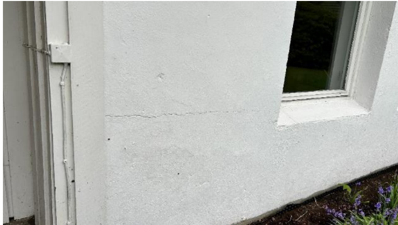
Horisontal sprekk i betongmur.
