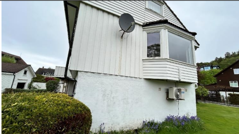
Foto nr. 2 Fasade mot sør.
