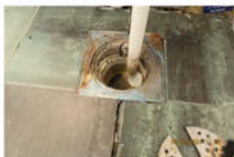
Sluk i vaskerom. UNDERETASJE > VASKEROM
