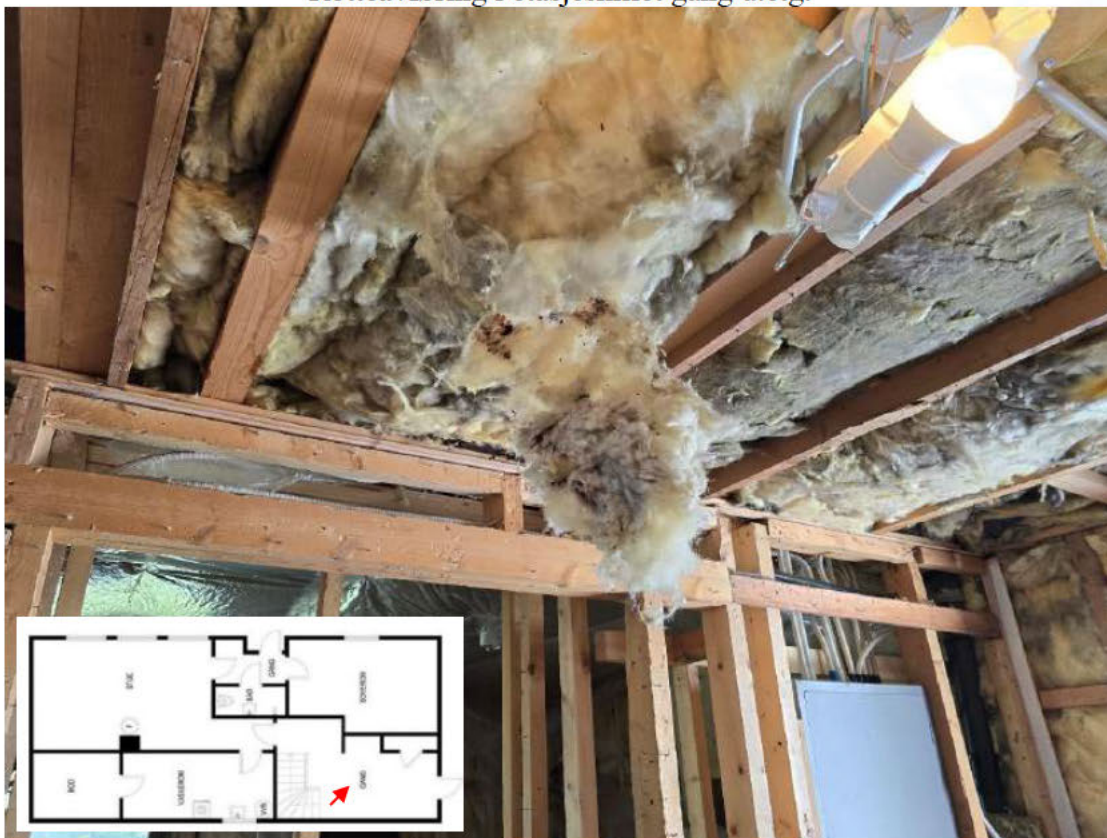
Vedlegg 1 - Foto nr.36. Rottereir i etasjeskillet mellom 1 og 2. etg.
