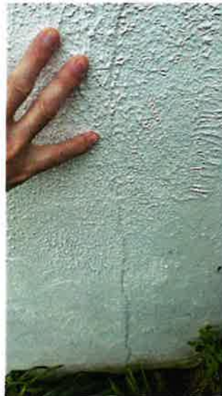
Horisontal sprekk i betongmur.
