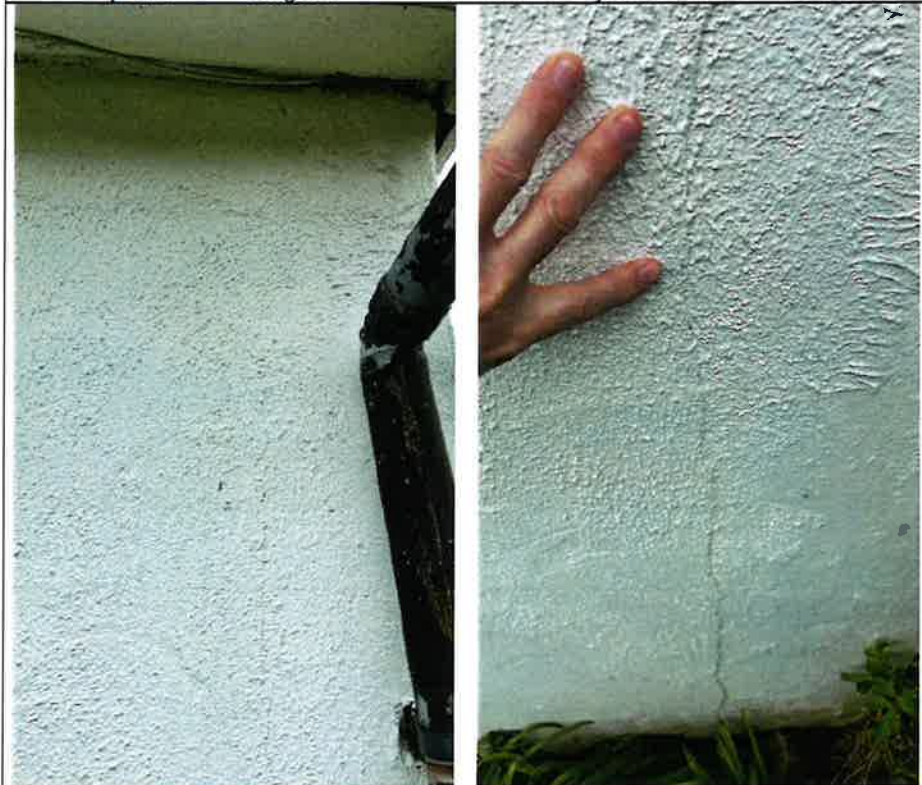
Foto nr. 6 Vertikal sprekk i vestre langside ca 20-25cm fra søndre hjørne.
