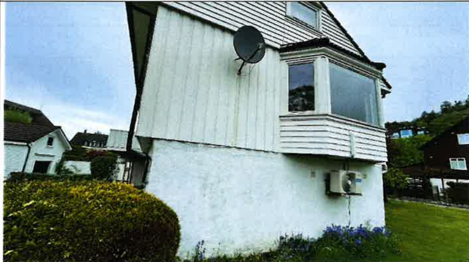
Foto nr. 2 Fasade mot sør.
