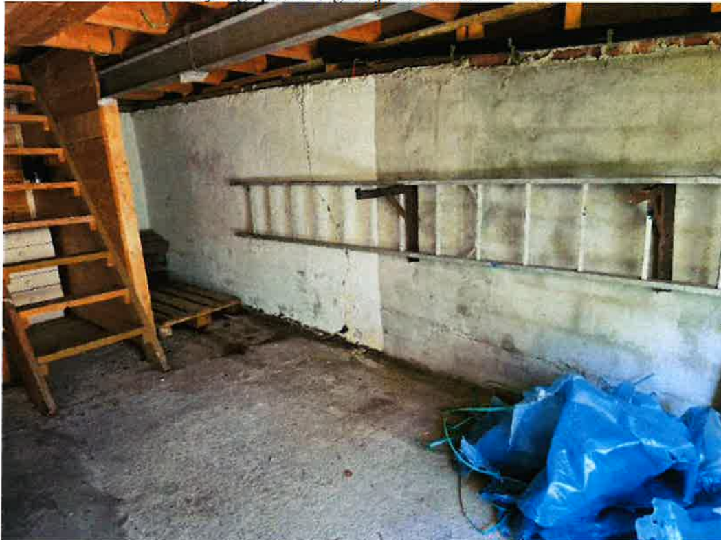
Vedlegg 1 - Foto nr.38. Synlig sprekk ei garasjens mur mot nabo.
