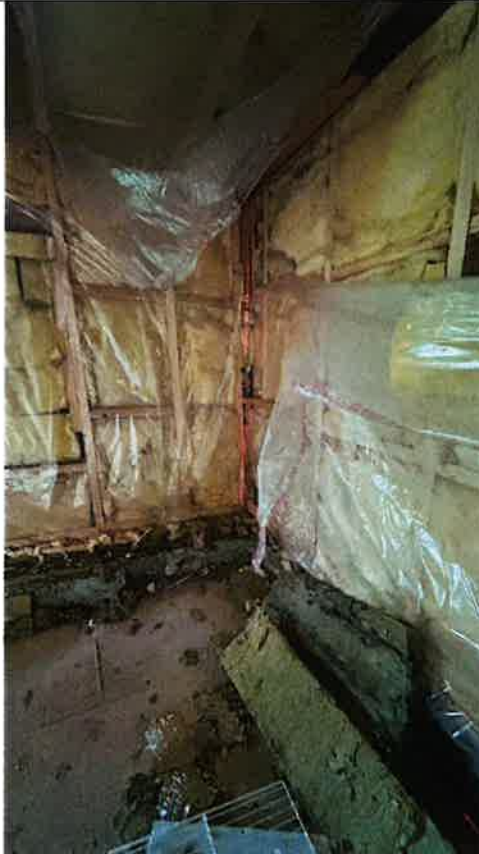
Foto nr. 40 Nordre hjørne er ca 10cm ut av lodd. Rød laserstråle viser lodd.
