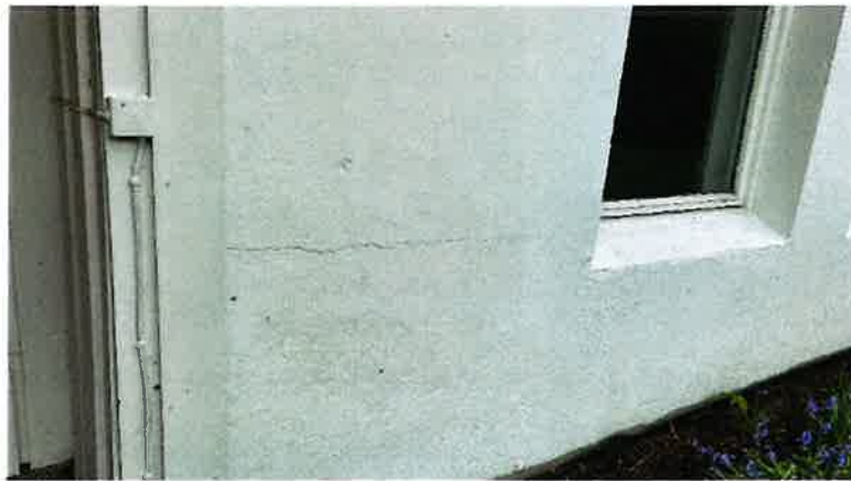
Horisontal sprekk i betongmur.
