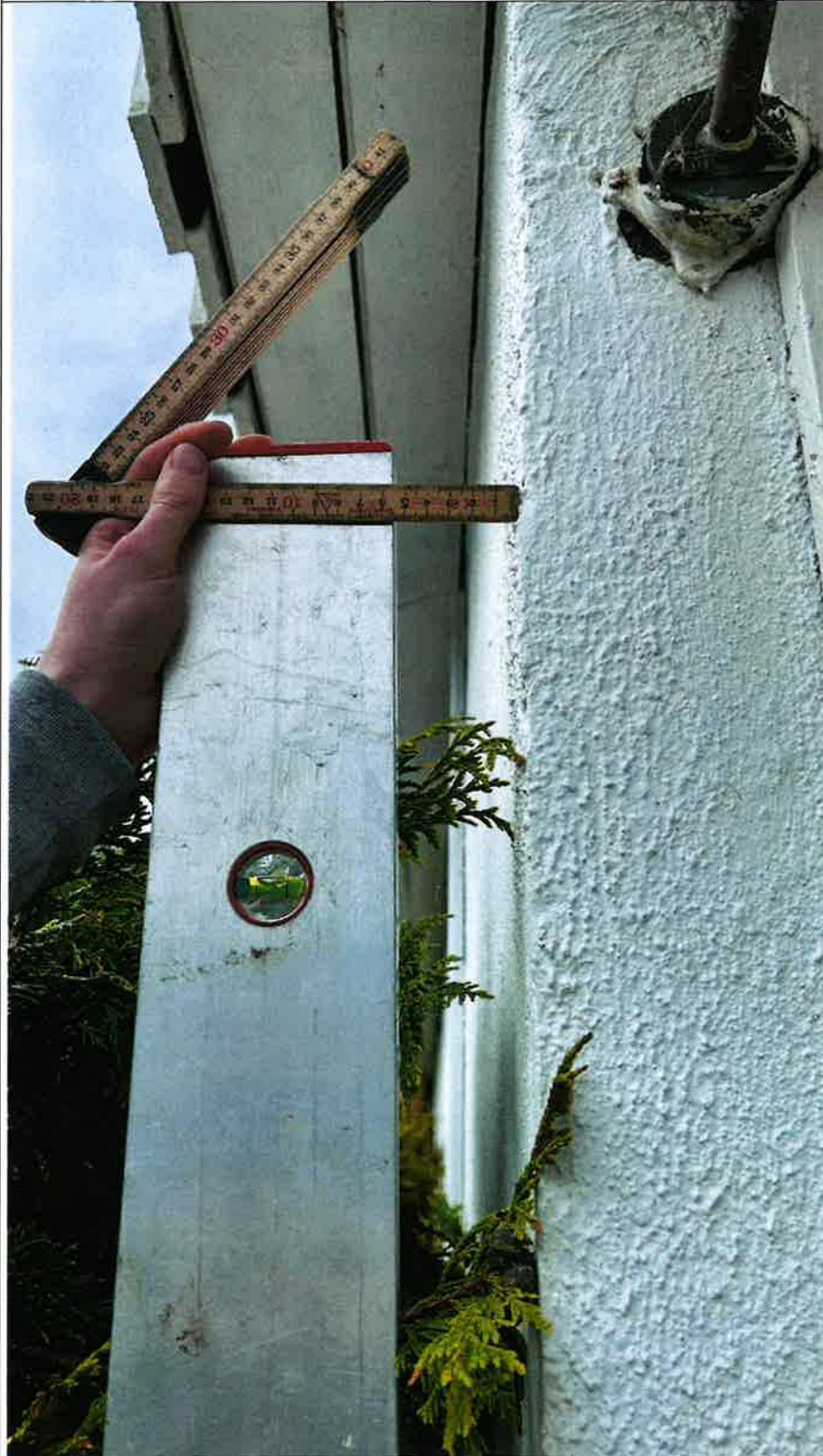
Foto nr. 13 Østre langside heller ca 5,5cm mot vest pr 1,8m høyde.
