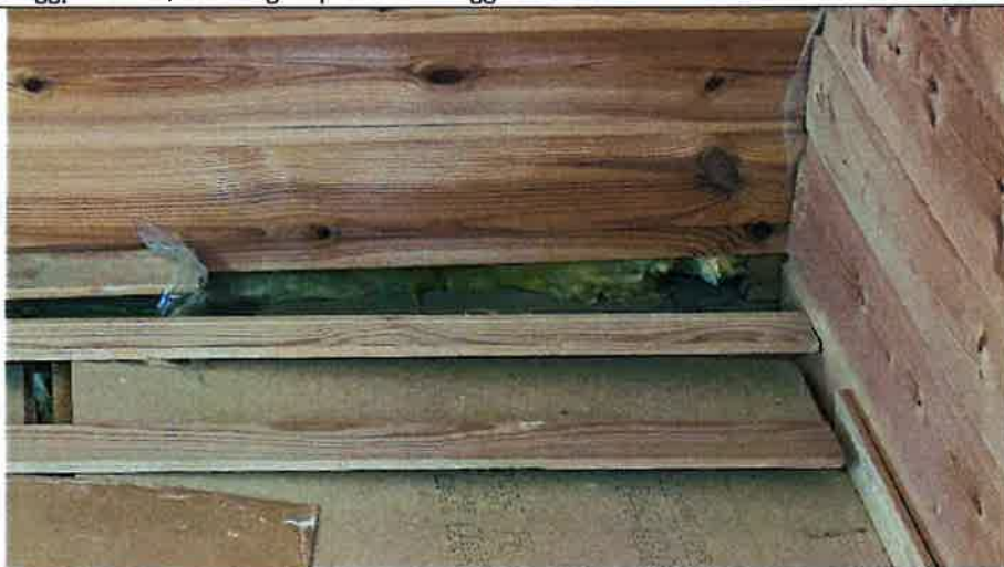
Foto nr. 55 Veggpanel er løftet fra gulv på loft for å ligge i vater.
