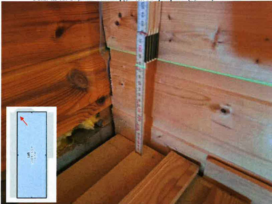
Vedlegg 1 - Foto nr.28. Målt til ca. 17,5cm. Justert pga. ekstra sponplate (2,4 cm) = 20 cm
