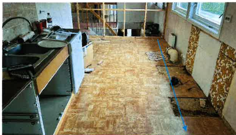
66mm fall mot nord på kjøkken.
