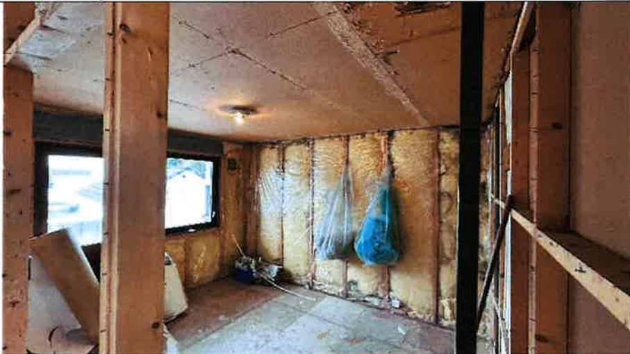
Foto nr. 51 Soverom 2.etg
