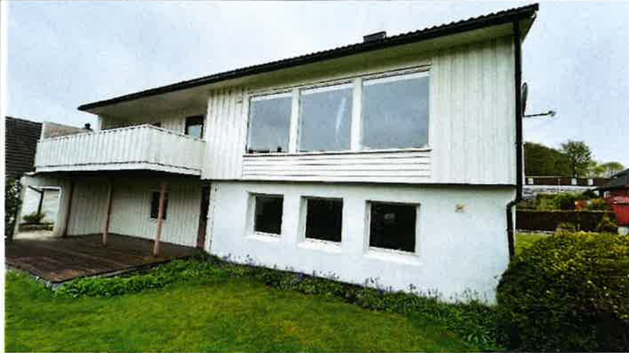
Foto nr. 1 Fasade mot vest.
