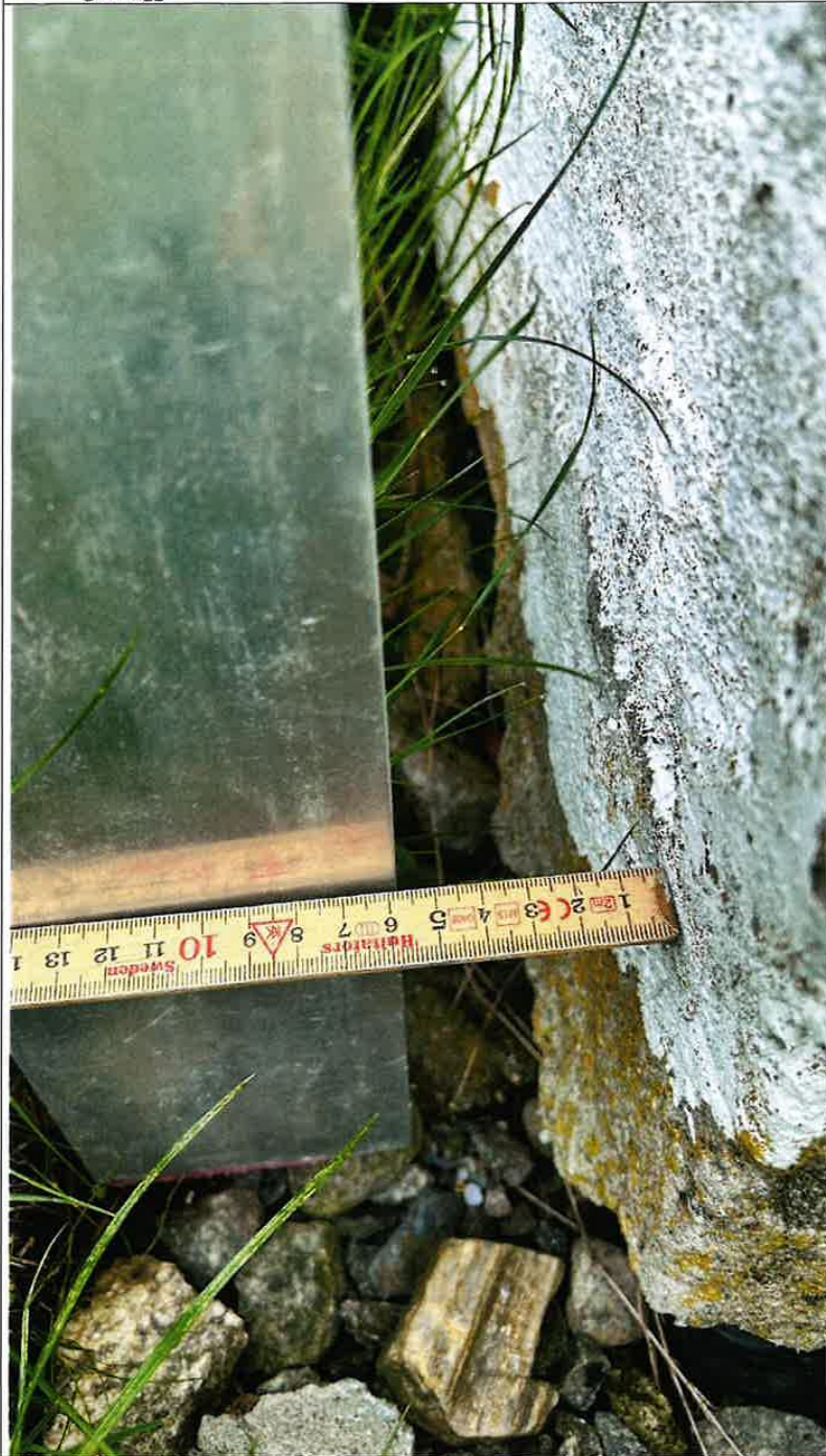
Foto nr. 17 Søndre gavlvegg heller ca 6 cm mot sør.
