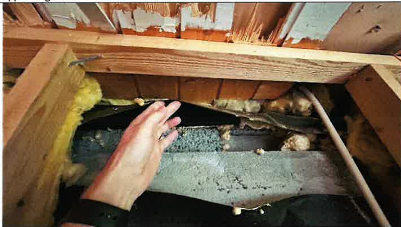
Foto nr. 43 Foto tatt i topp av grunnmur mot sør. Det er lagt lecamur oppå grunnmur ifm oppretting.
