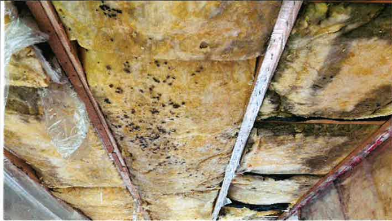
Foto nr. 46 Avføring etter rotter over stue.
