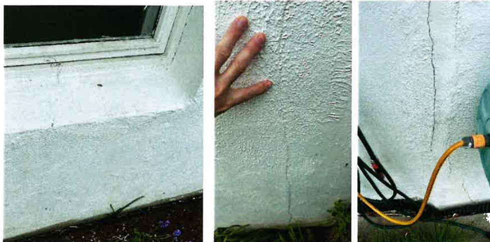
Horisontal sprekk i betongmur.
