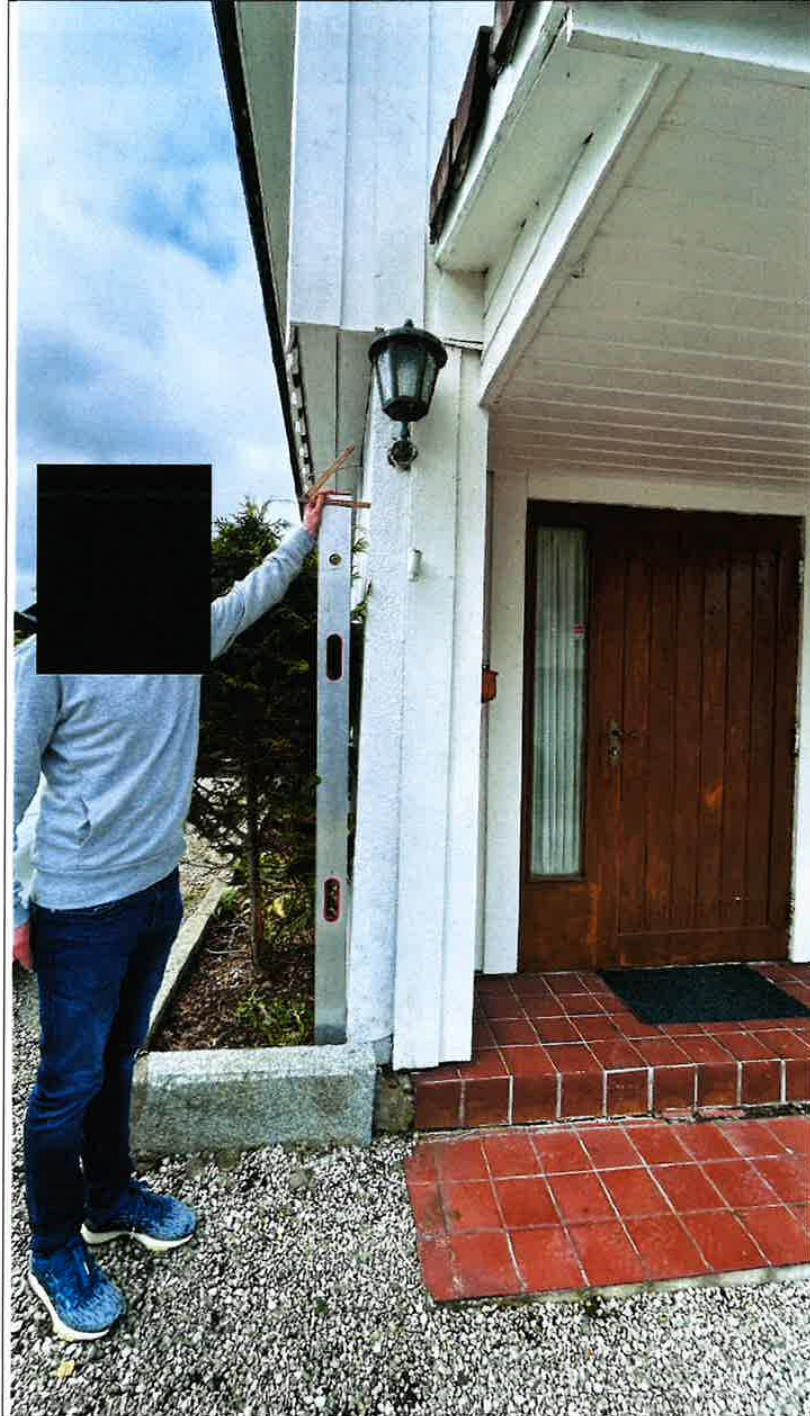
Foto nr. 12 Nordre gavlvegg heller ca 5,5cm mot vest pr 1,8m høyde. Jmf neste foto.
