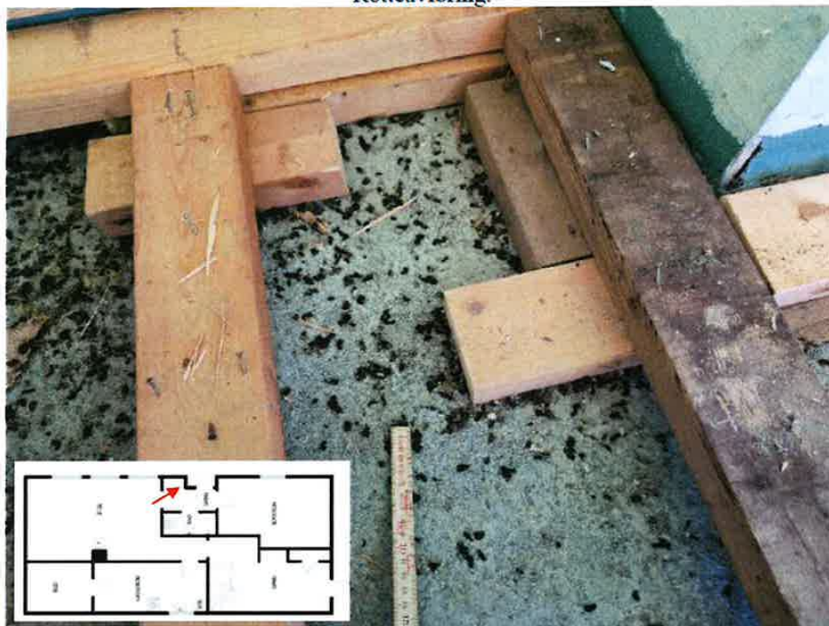
Vedlegg 1 - Foto nr.32. Rotteavføring.
