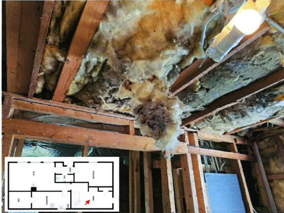
Vedlegg 1 - Foto nr.36. Rotteir i etasjeskillet mellom 1 og 2. etg.
