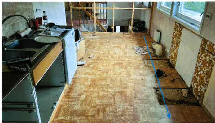
66mm fall mot nord på kjøkken.
