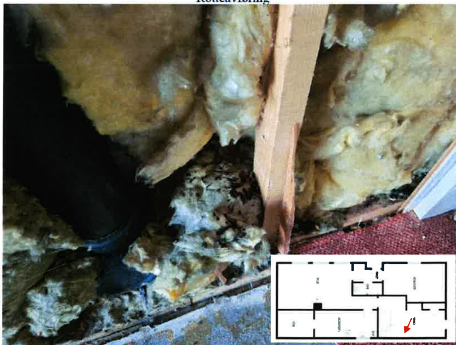
Vedlegg 1 - Foto nr.34. Rotteavføring
