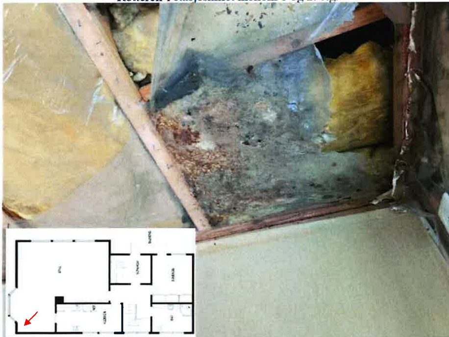
Vedlegg 1 - Foto nr.36. Rotteir i etasjeskillet mellom 1 og 2. etg.
