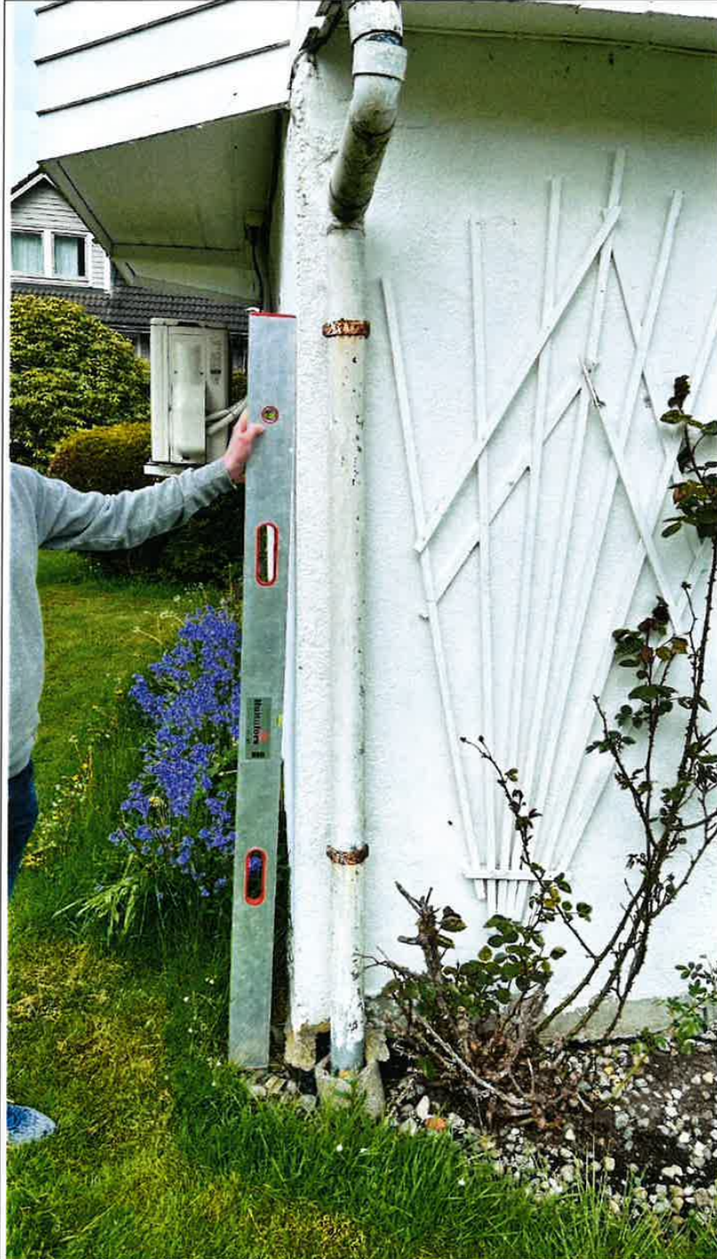
Foto nr. 16 Søndre gavlvegg heller ca 6 cm mot sør, jmf neste foto.
