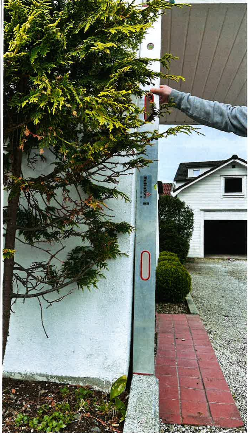
Foto nr. 14 Nordre gavl heller utover mot nord.
