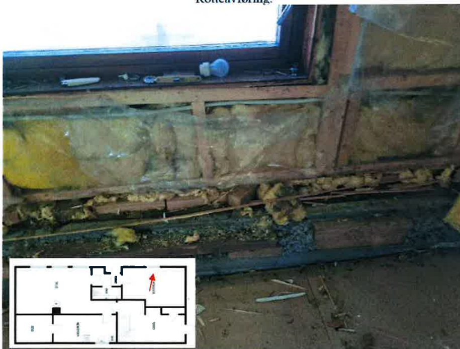
Vedlegg 1 - Foto nr.32. Rotteavføring.
