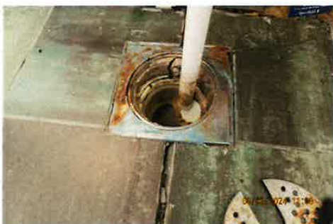
Sluk i vaskerom.
