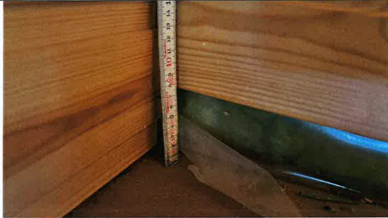
Foto nr. 54 Panel på knevegger er løftet over 7cm for å legges i våter- Gulv er altså tilsvarende skeivt her.
