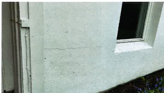
Horisontal sprekk i betongmur.
