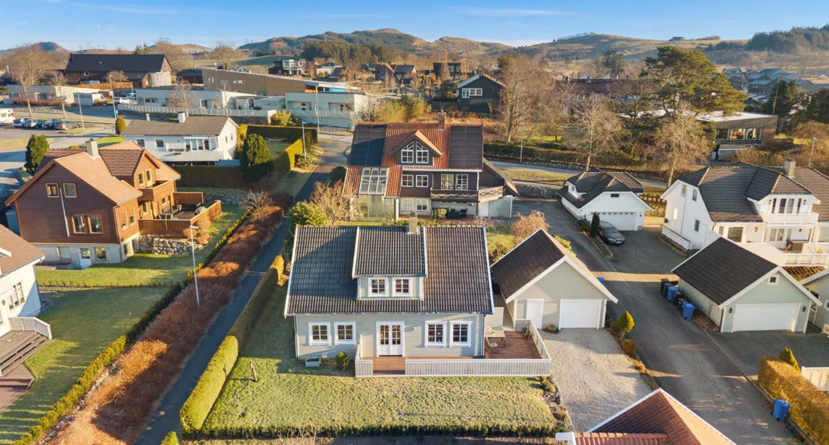
Innkjørsel og gårdsrom er singlet med god oppstillingsplass til flere biler.
