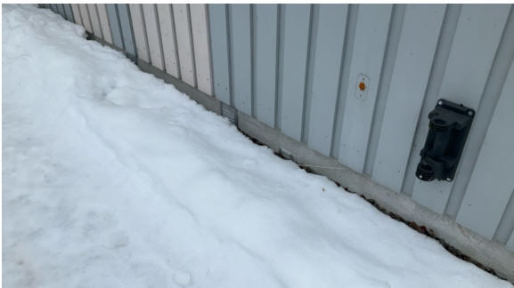
Viktig å følge med på ventiler som ligger helt ned mot terrenget slik at det ikke oppstår vannskader.
