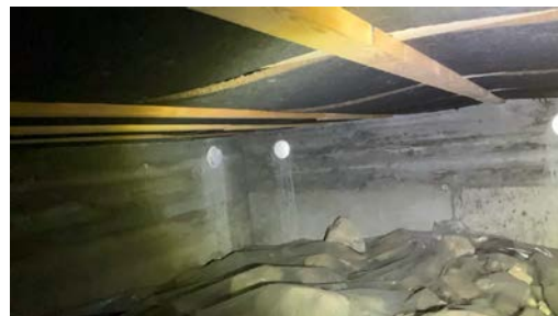
Kryperom fremstod som luftig på befaringsdagen.
