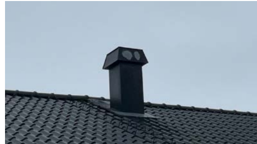
Flassing på takrenner/beslag.
