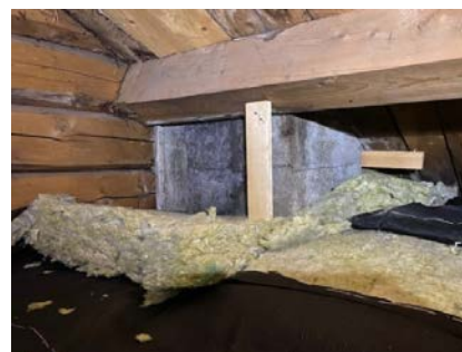
Pipe på kaldloft
