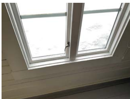
Vindu på stellerom hovedetasje.
