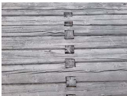
Utvendig tømmervegg.
