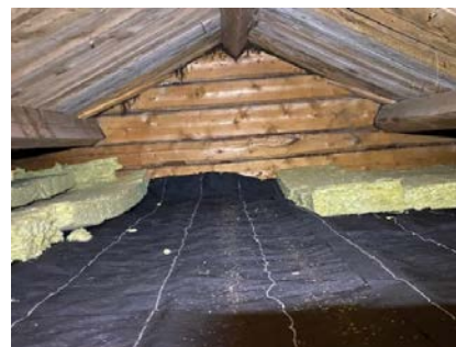
Gavlvegg mot sørøst.
