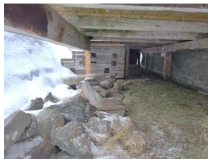
Konstruksjon av inngangsparti.
