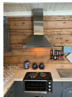
Ventilasjon med kullfilter over kokesone.
