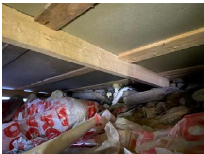
Vannfaste sponplater som stubbegulv.
