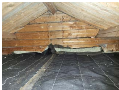
Gavlvegg mot nordvest.
