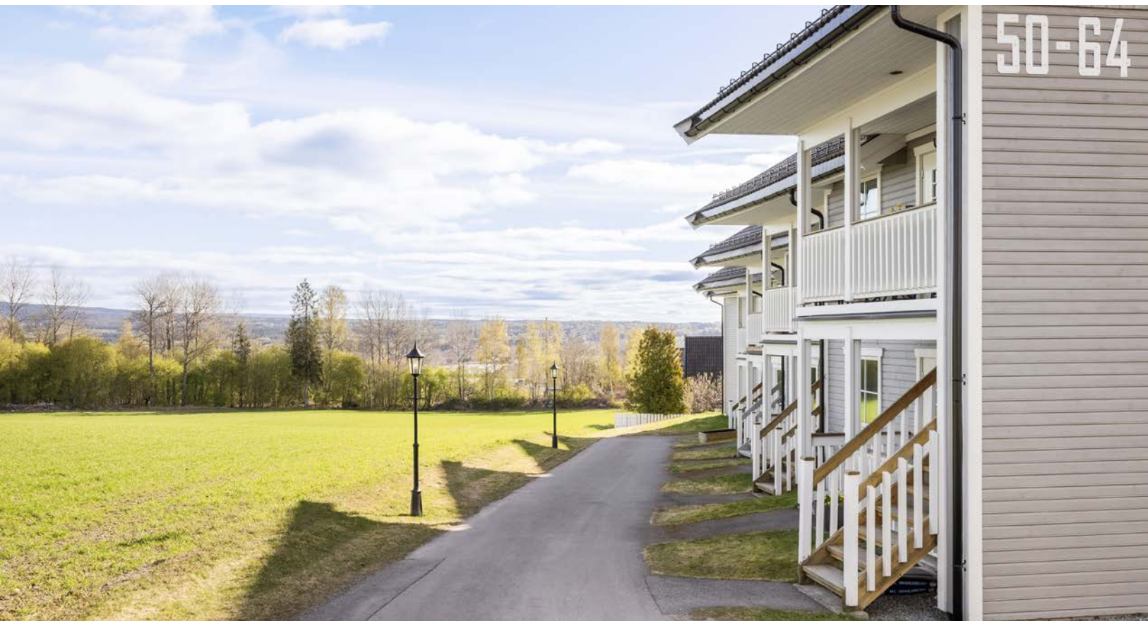
Sameiets eiendom er pent opparbeidet med asfalterte og opplyste internveier.
