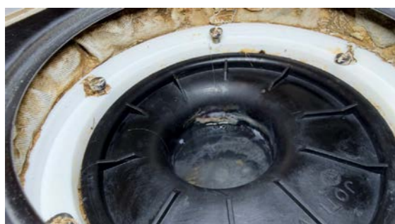
Løse skruer på klemring
