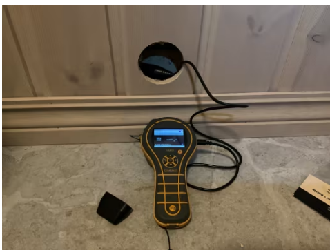
Hulltaking i tilstøtende rom.
