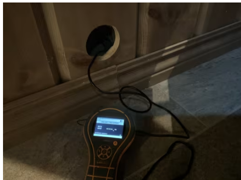
Hulltaking i tilstøtende rom.
