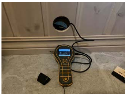
Hulltaking i tilstøtende rom.
