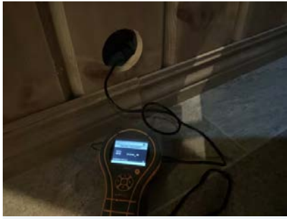
Hulltaking i tilstøtende rom.
