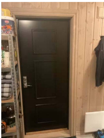
Dør ut fra bod/teknisk.
