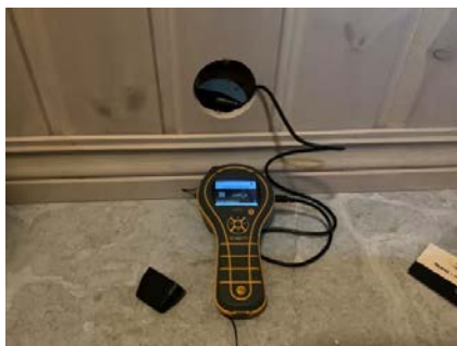
Hulltaking i tilstøtende rom.
