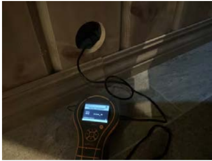
Hulltaking i tilstøtende rom.
