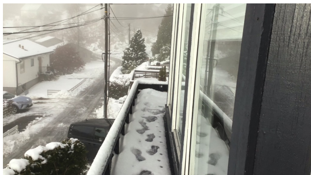
Rekkverk rundt tilbygget av meget lav høyde
