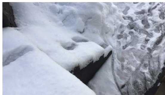
Mangler rekkverk på trapp ved kjellerdør
