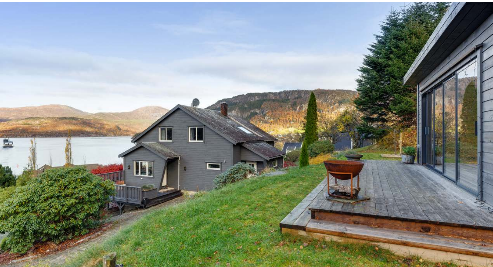
Nyere hagestue som er plassert i øvre del av tomten
