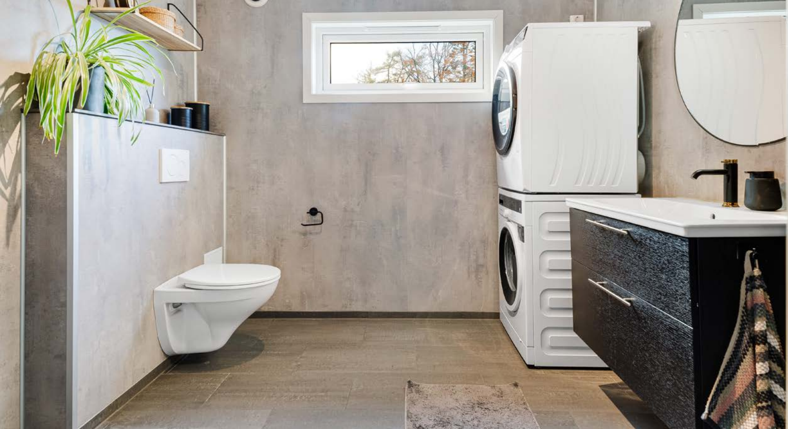
Nyere baderom med flislagt gulv og våtromsplater på vegger
