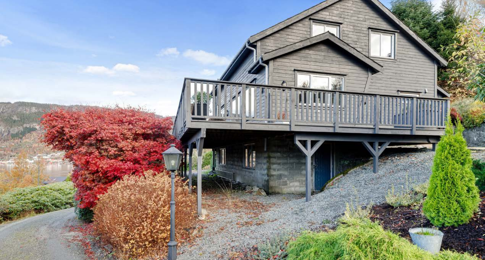
Boligen har fått ny kledning og omtrent alle vinduer er skiftet i løpet av de siste årene
