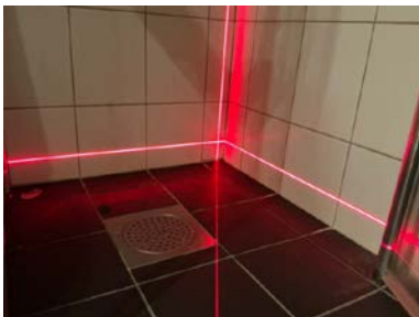
Fall på badergulv er kontrollert med krysslaser.
