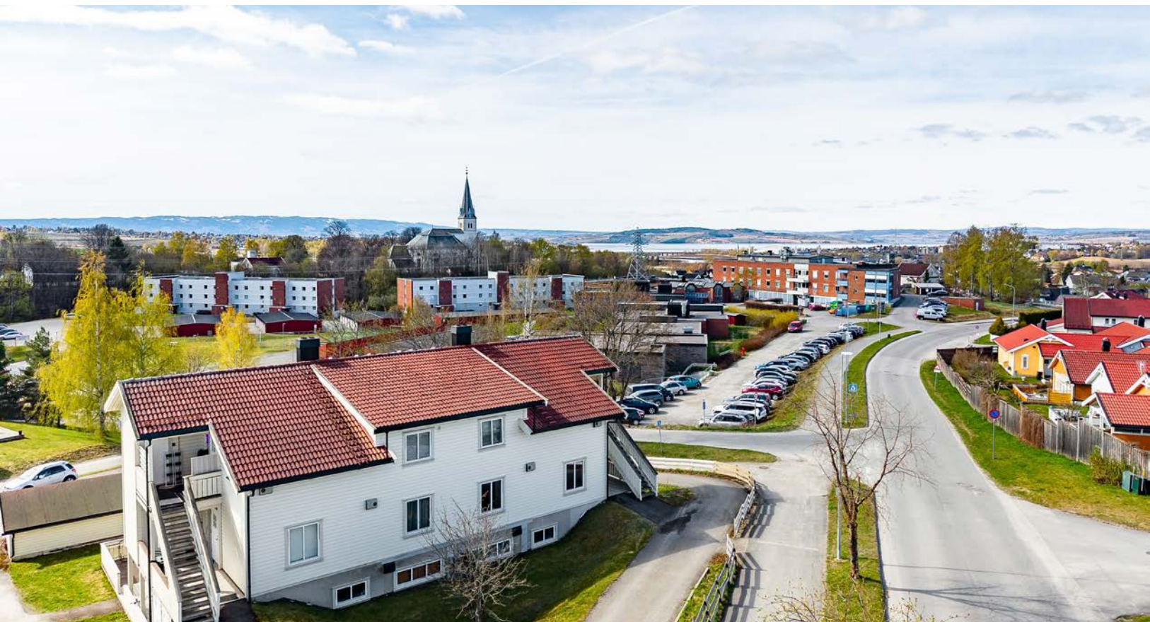
Innganger på høyre side av bygget. Det er totalt 6 leiligheter i bygget og sameiet består totalt av 26 leiligheter.
