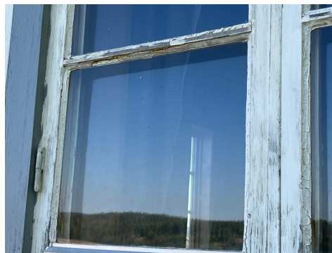
Stor værslitasje, kitt rundt glass er borte
