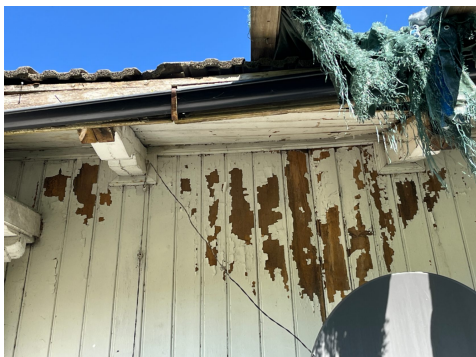
Råteskadet kledning
