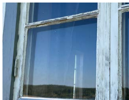
Stor værslitasje, kitt rundt glass er borte
