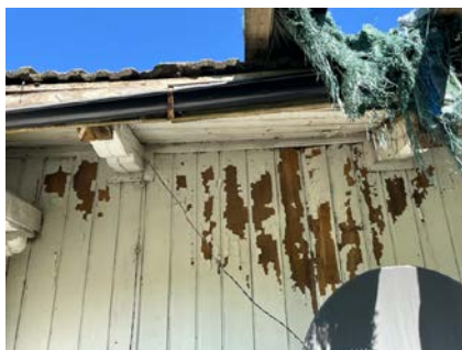
Råteskadet kledning
