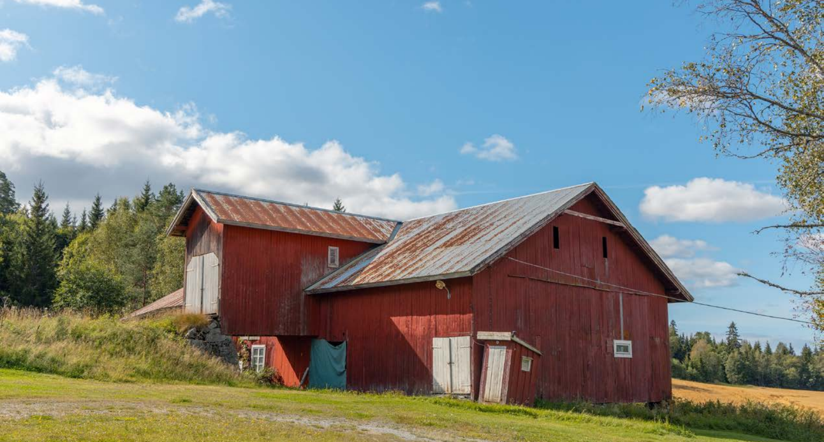
I bakkant ligger driftsbygningen med låve, stall og lagerrom.
