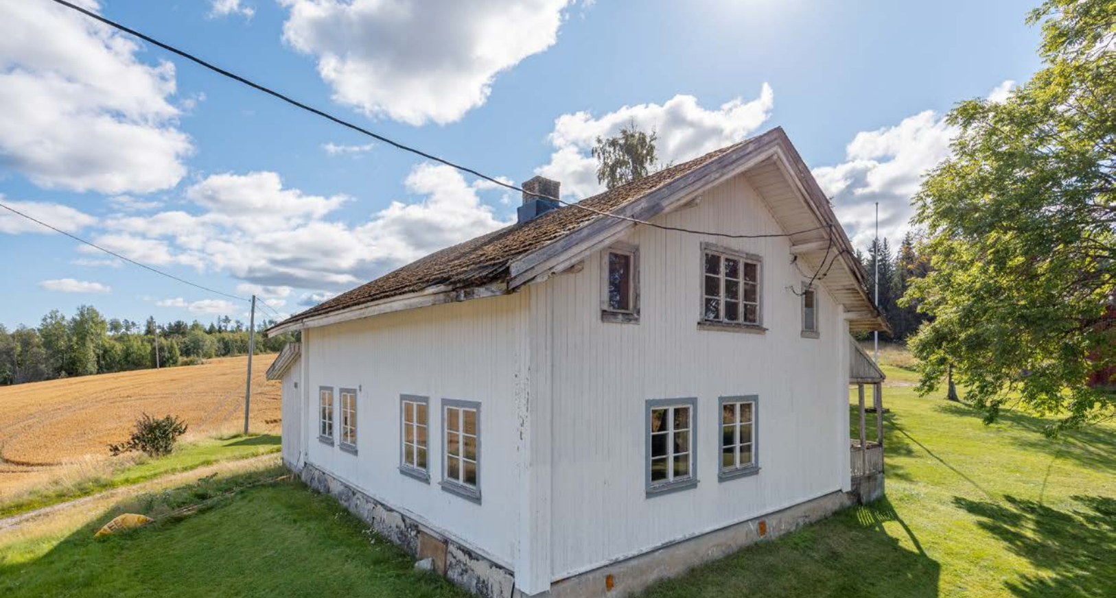
Boligen er påbygd i flere omganger og i behov av renovering.
