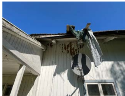
Deformasjoner på takrenne
