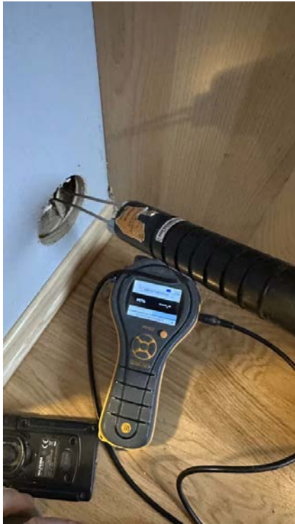
Ingen registrert fukt ved hulltaking.
