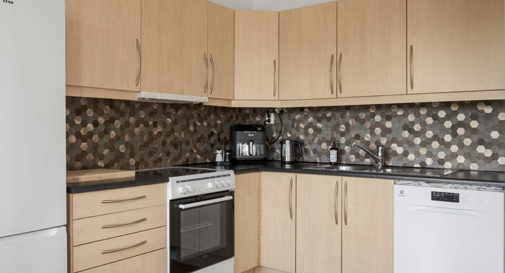
Kjøkkeninnredning i vinkel med glatte, lyse fronter og laminat benkeplate med nedfelt rustfri servant med sidefelt.
