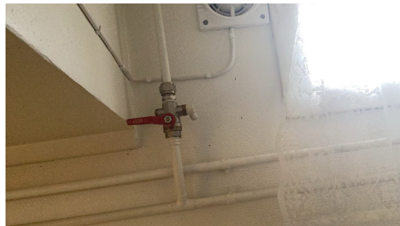
Stoppekran for vann til utekran
