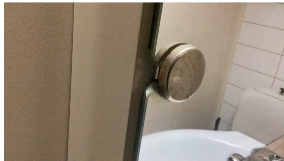
Det er noen mindre skader på speil.
