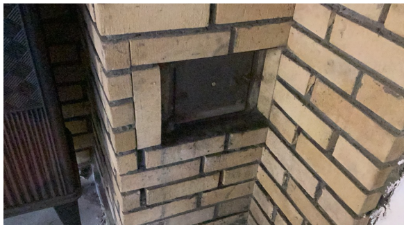
Sotluke i kjeller.
