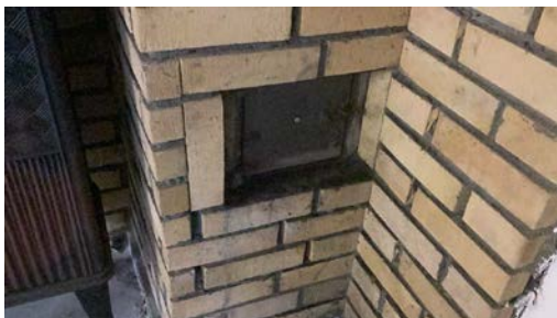
Sotluke i kjeller.
