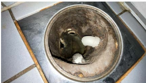
Soilsluk i dusjnise.
