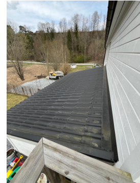
Bilde er tatt i forbindelse med befaring i april 2025
