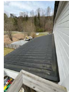
Bilde er tatt i forbindelse med befaring i april 2025
