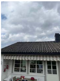
Bilde fra befaring i april 2025, taket har i ettertid blitt spylt av nåværende eier
