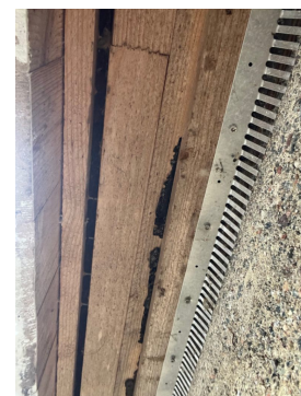
Bilde underkant av kledning på tilbygg.
