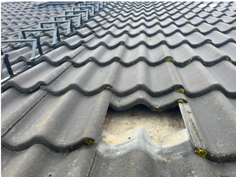
Taktekking på eldre del.
