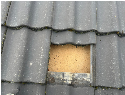
Taktekking på tilbygg.
