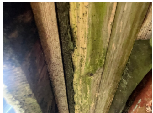
Bilde underkant av kledning på eldre del.
