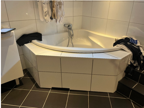
Innbygget badekar med spalte i nedkant til sluk.
