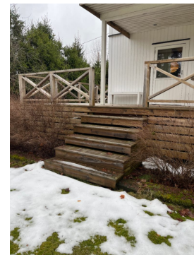
Trapp og rekkverk på terrasse er ikke iht. dagens krav.
