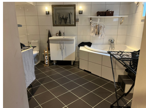
Bad/vaskerom i innredet kjeller.
