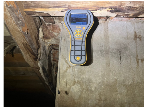
Fuktmåling ved pipe viste normale verdier.
