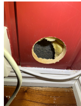
Hulltaking avdekket fuktig isolasjon og plast på yttervegg.
