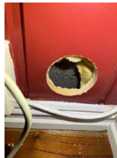
Hulltaking avdekket fuktig isolasjon og plast på yttervegg.
