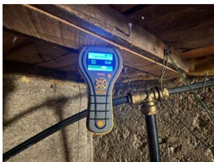
Fuktmålinger viste normal fukt i trevirke.
