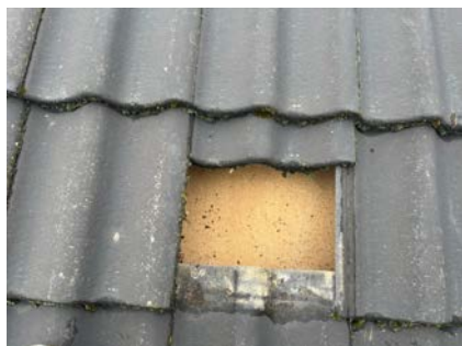
Taktekking på tilbygg.
