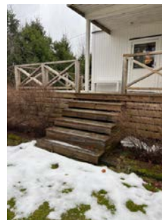
Trapp og rekkverk på terrasse er ikke iht. dagens krav.
