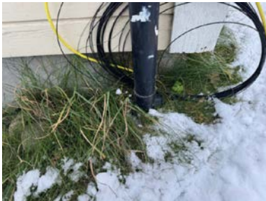
Nedløp som er avsluttet ved grunnmuren.
