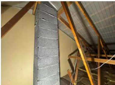
Sperre som er modifisert for å få plass til pipen.
